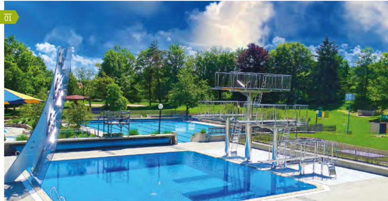
„Rigi Rutsch'n“ heißt das Freibad im beschaulichen Peißenberg (Bayern). Des- sen 40 Jahre alte Sprungturmanlage aus Stahlbeton und die Rutschenanlage wurden im Zuge der Sanierung des Bades gegen eine neue aus Edelstahl ausgetauscht.
