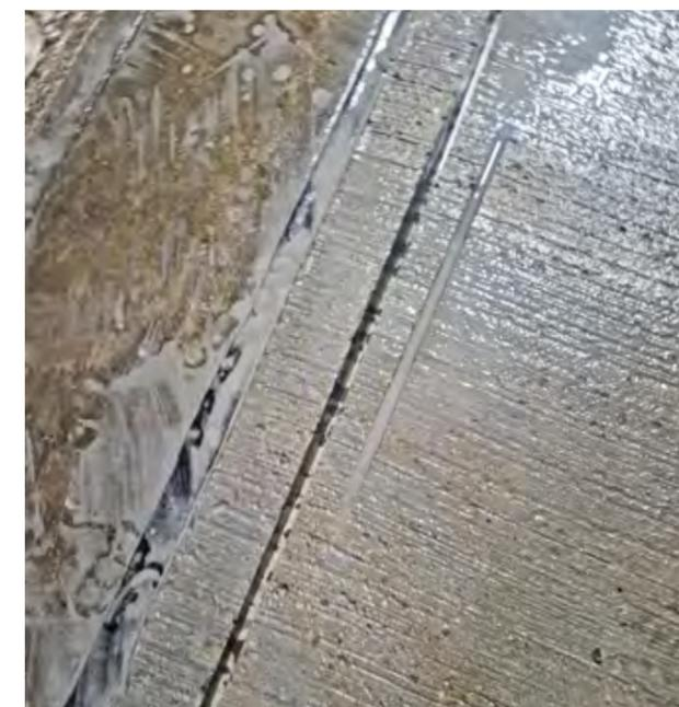
Präzision hart an der Kante. Exakt geradeaus und genau 40 Millimeter tief muss die Fuge für die Beleuchtungskabel verlaufen.
