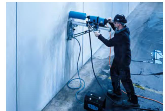
Die optisch identischen Bohrmotoren DME26 und DME32 sind mit 2,6 bzw. 3,2 Kilowatt Leistung bestens geeignet für Betonbohr-Profis.
