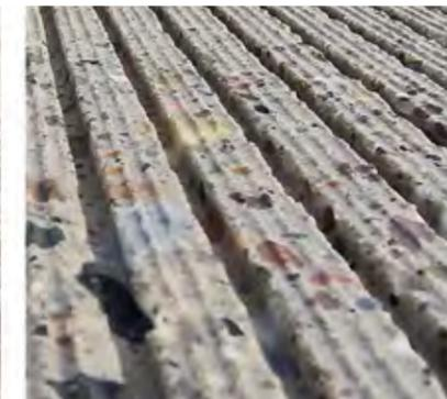
Fahrbahnoberfläche nach 7 Monaten (l.) im Vergleich zum Zustand nach der Erstellung (r.).
