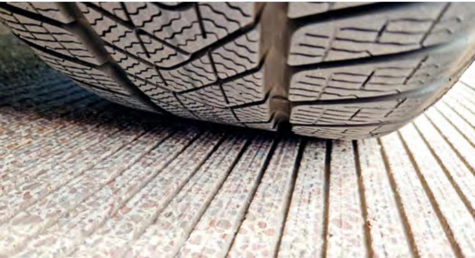
Für mehr Sicherheit und weniger Lärm – Fahrbahnoberfläche mit Future-Grinding.
