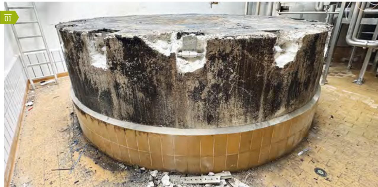
Die Deutsche Milchkontor GmbH produziert am Standort Nordhackstedt Mozzarella, eine der beliebtesten Käsesorten der Welt, sowie Schnittkäse. Im Rahmen der Modernisierung der Produktionsanlagen wurden zwei Edelstahlbehälter demontiert. Den Rückbau der Stahlbetonsockel und eine 40 Quadrat-
