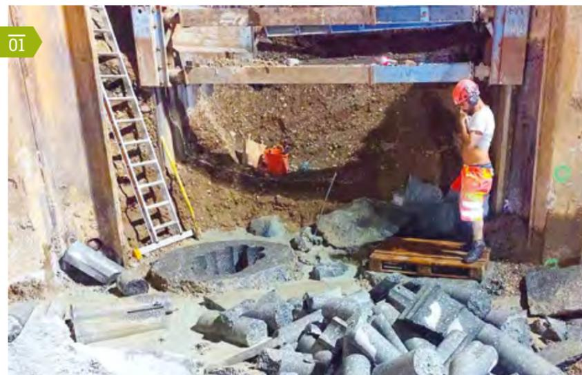
Für eine provisorische Brücke mussten beim rechten Brückende Auflager erstellt werden auf zwei Bohrpfeilern. Um die Brücke zu lagern, wurde eine Stahlkonstruktion vorbereitet und mit einem Kran in die richtige Position gebracht.
